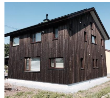
木材を外装材に用いた住宅
