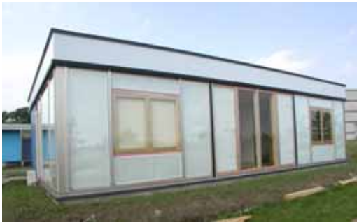
光透過壁を用いた実験住宅（外観）
