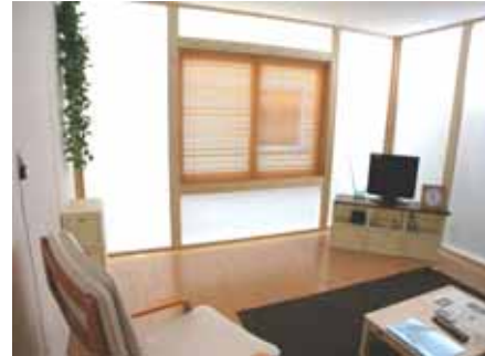
光透過壁を用いた実験住宅（内観）
