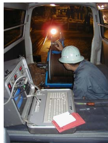
虹田町月浦温泉ボーリング現場での検層の様子
