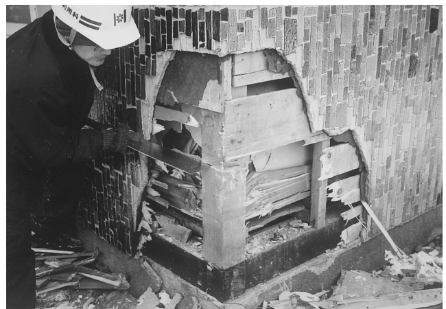
写真1 サンプル採取(土台はクレオソート処理材)
