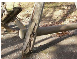
写真4 地際の腐朽
