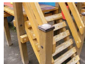
写真8-3 異種素材による木口保護例3
