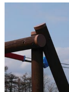
写真8-2 異種素材による木口保護例2
