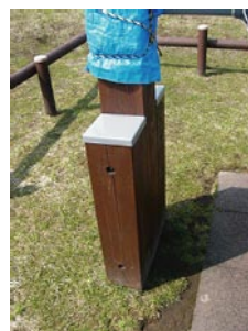
写真8-1 異種素材による木口保護例1
