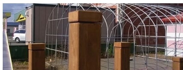
写真9 アセチル化木材による木口の保護
