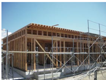
写真1 芦別市の木造公営住宅
