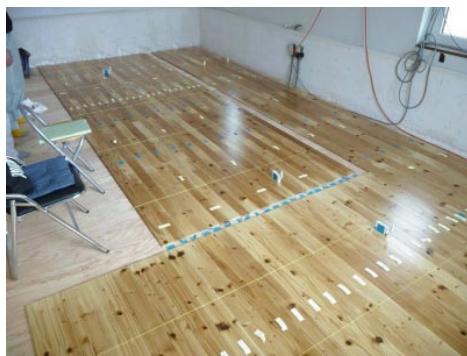
写真4 実験住宅での施工試験
