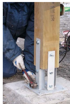
写真7: 平金物による柱の固定
