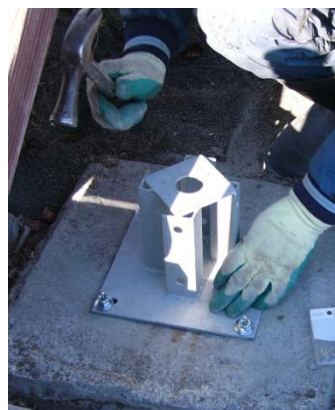
写真6: かさ上げ金具の取り付け
