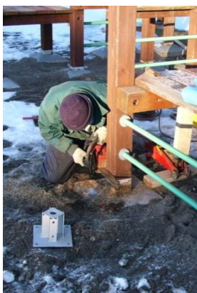
写真5: 腐朽部位の除去
