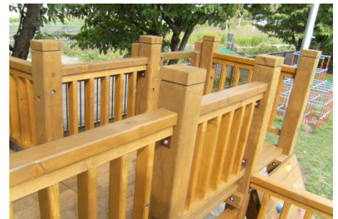
写真4: 柱頭と手摺横木の保護
