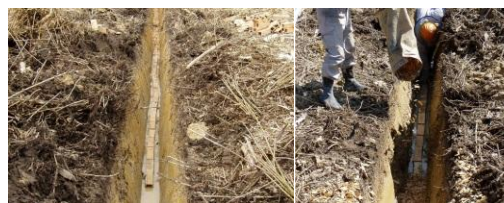
暗渠排水管埋設状況
