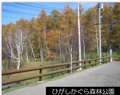
図3 実際の施工物(実物)
