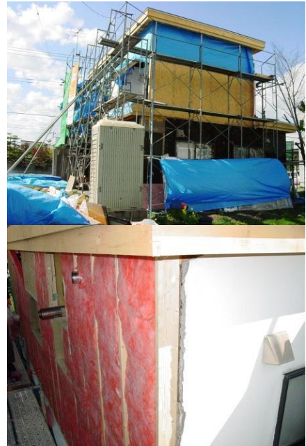
写真2 200mm断熱リフォーム (2006年旭川)
