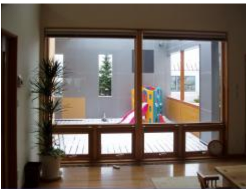
写真5 木製サッシの例(その1)
