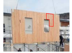
開口部をくり抜いたCLTパネル(赤枠がL形)
