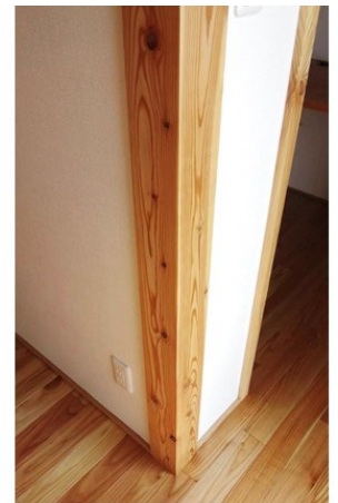
写真1 真壁構法に使用されたカラマツ心持ち柱
