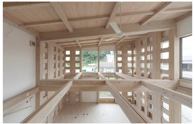
写真6 建方終了後の内観
