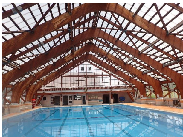
写真1 屋内温水プール（蘭越町）
