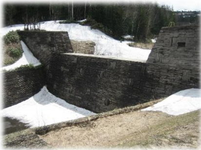
砂防ダム(木製化粧パネル)
