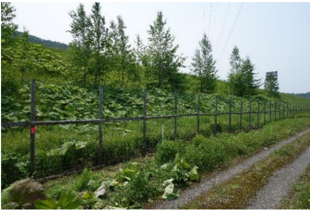
写真5 木製立入防止柵（上川町）
