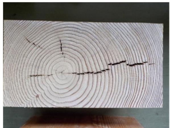
写真2 乾燥により生じた内部割れ
