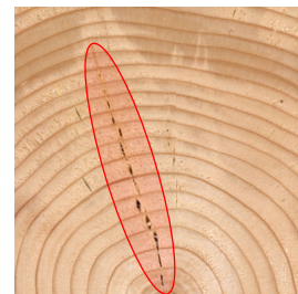
写真2 多年輪に跨がる割れ
