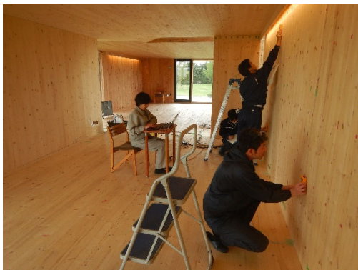
図5 壁パネルの表面形状測定
