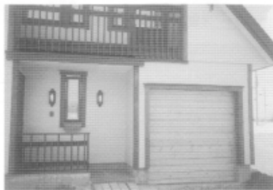
写真1 住宅の組み込み車庫に使用されているオーバースライド式木製シャッター
