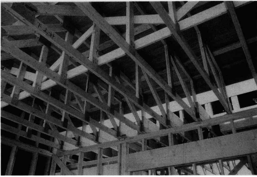
写真2 無落雪屋根への利用例
