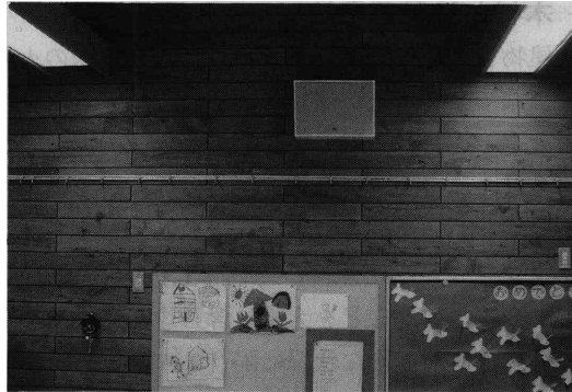
写真2 釜利谷幼稚園（横浜市）
