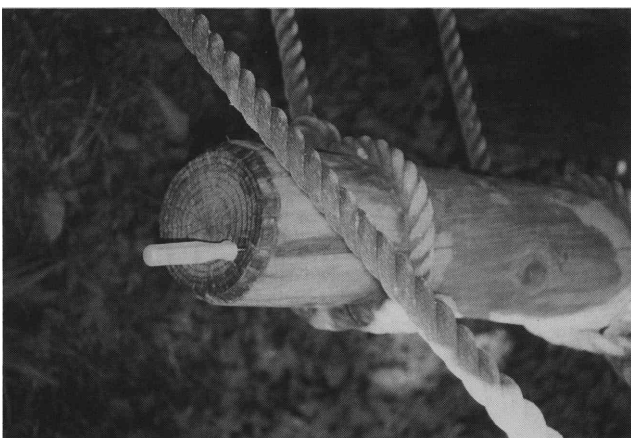
写真2 木口の腐朽
