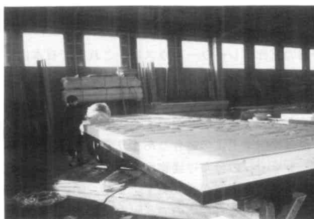
写真4 床下地材と断熱材の施工
