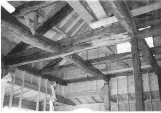
写真6 古い民家の材を再利用した住宅の例
