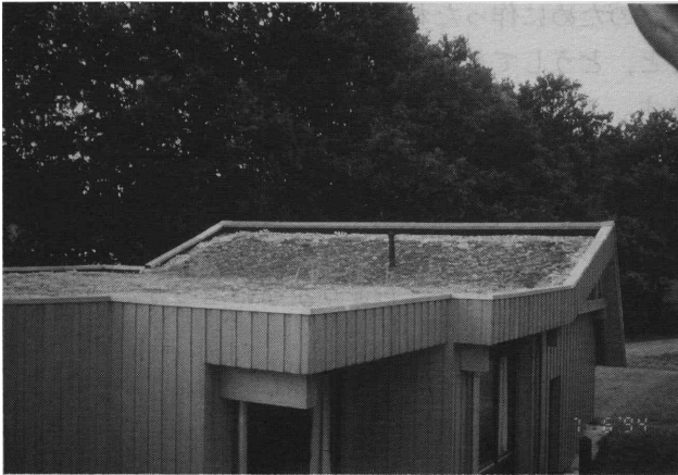
写真10 屋上緑化の建物（ドイツ）
