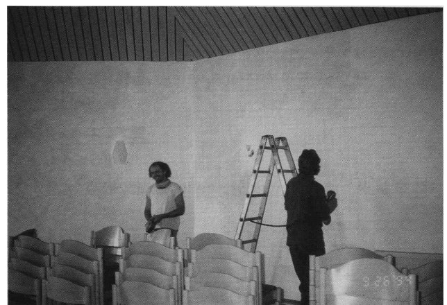
写真12 ボランティアによる教室内部の塗装（自然塗料を使ってる）
