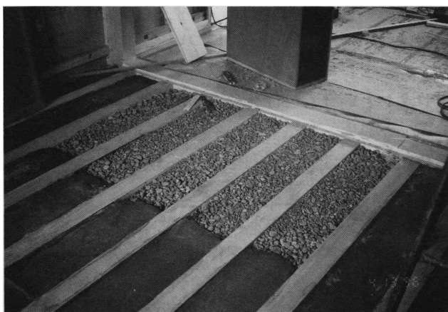
写真8 実験中の床暖房フロアの下地
