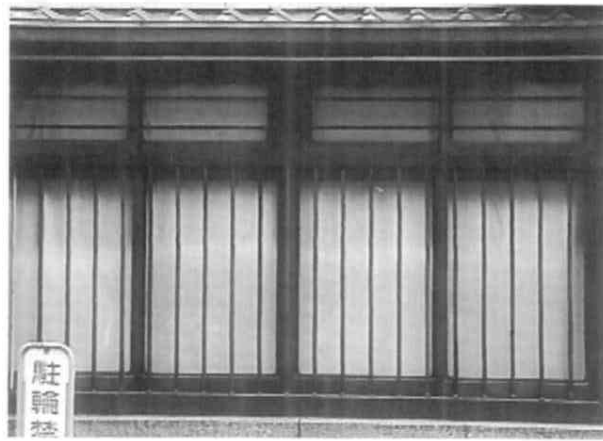
写真5 鉄丸棒の格子
