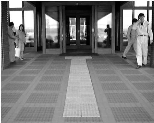
写真1 林産試験場玄関アプローチの敷設状況
