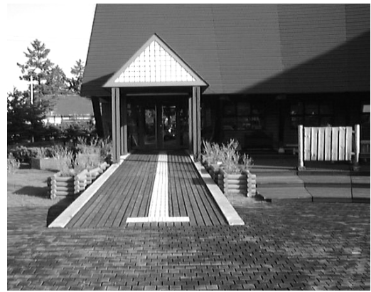
写真2 木と暮らしの情報館（林産試験場内施設）玄関アプローチの敷設状況
