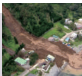
↑写真1 2016年8月の豪雨による斜面崩壊
