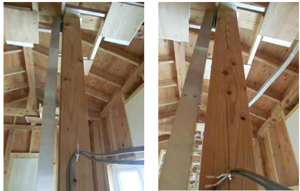
(a) 含水率11%以下 (b) 含水率15%以下 図2-2-1-8 ひと冬経過後の柱
