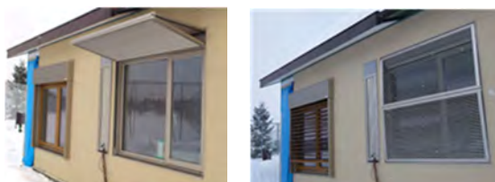
(左の写真: 外付けルーバー開, 右の写真: 外付けルーバー閉) 図2-1-3-4 Smart-Window試作品
