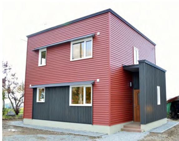
図2-3-2-5 実証住宅外観
