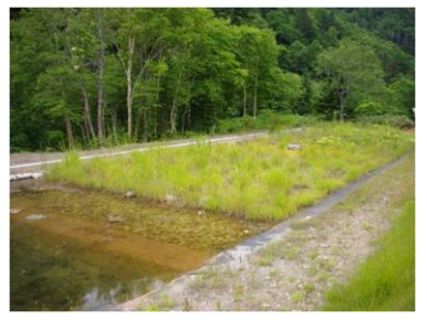
石灰石の砕石を使用。 酸性の廃水を中和して、亜鉛、鉛などを湿地内部で除去。
