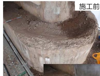
凍結融解の繰り返し等により、ひび割れ、剥落の生じた橋脚劣化部分の開発材料による補修施工事例
