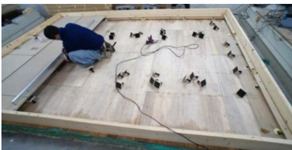
遮音二重床の施工状況
