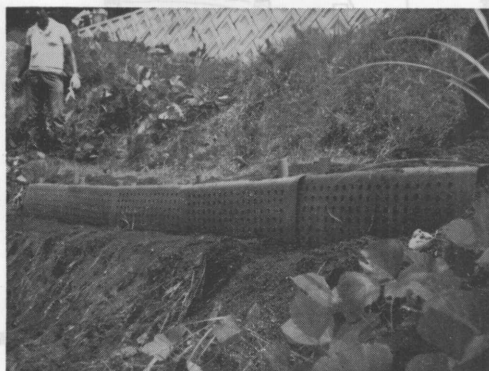
写真1 ハードボード製土留め材の使用例
