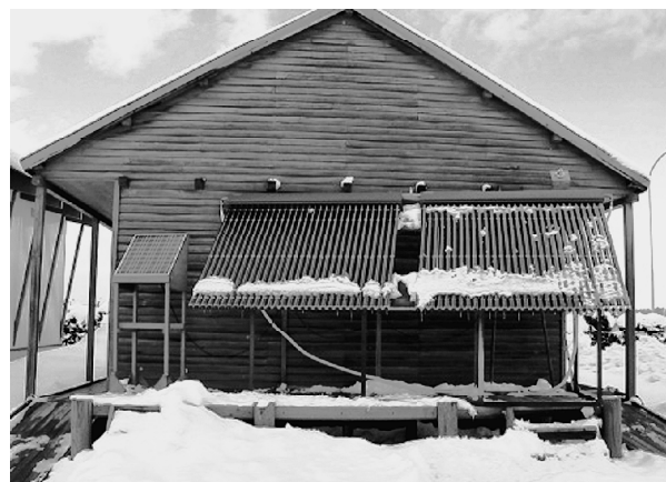
第1図 集熱器の外観
