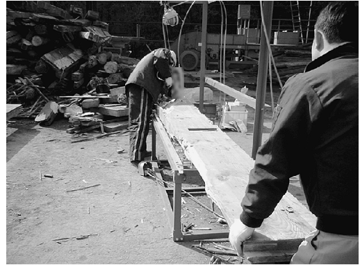
第 1 図 釘抜き装置を用いた釘抜き作業
