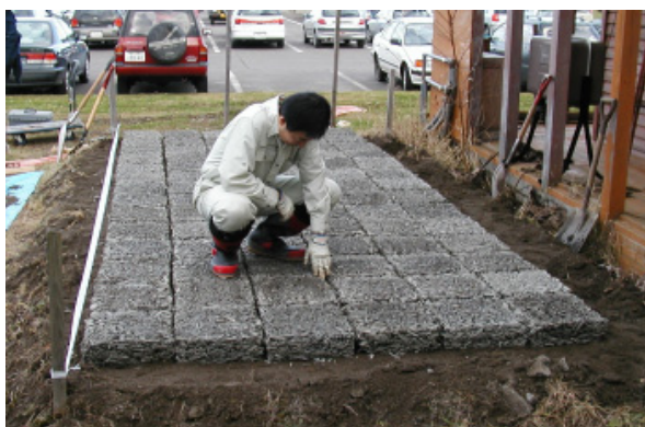
第 2 図 木質・セメント成形体による融雪路盤
