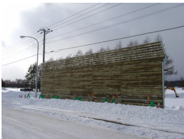
第1図 木製防雪柵プロトタイプ
