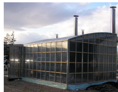
第 2 図 太陽熱木材乾燥装置（東西型）
