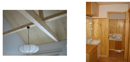
和室天井への施工
