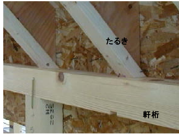
図20 軒の出がない場合のたるき固定
