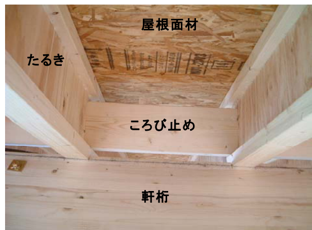
図22 ころび止め(上下部に通気スペース)
