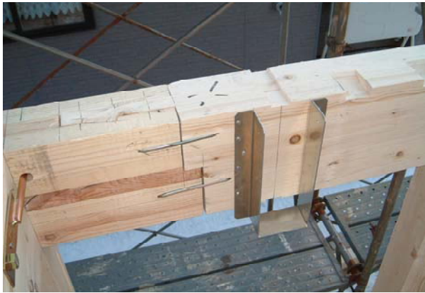
図14 床梁の継ぎ手と金物
