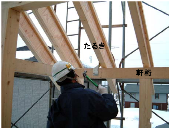
図19 軒の出がある場合の金物補強
