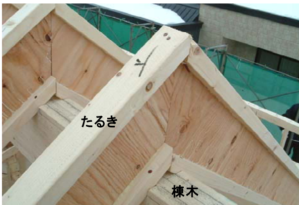
図17 棟木でのたるき固定
