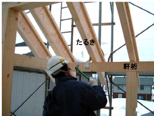
図19 軒の出がある場合の金物補強
