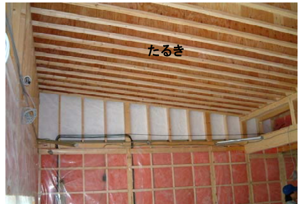
図16 屋根たるきの施工例
