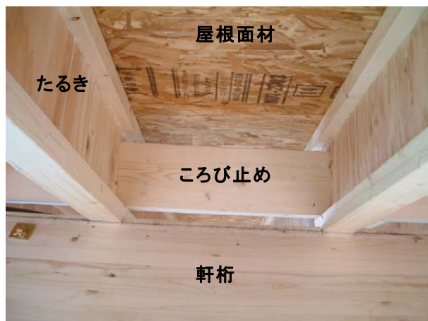
図22 ころび止め(上下部に通気スペース)
