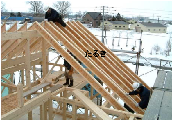
図16 屋根たるきの施工例
