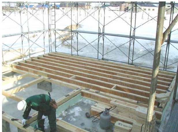
図8 1階床根太の長尺使用
