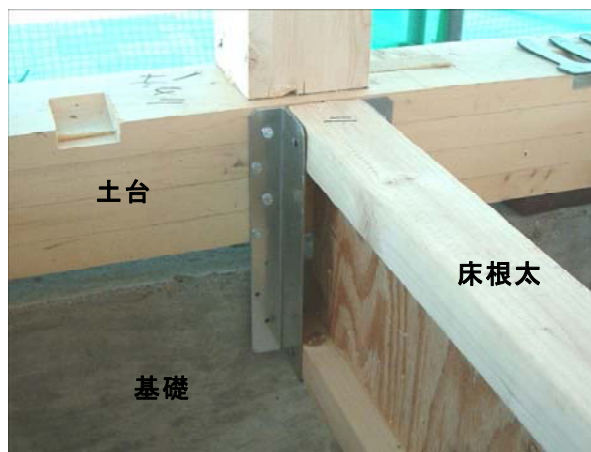
図7 床梁用金物の取り付け
