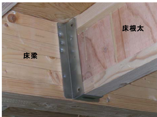
図10 床梁用金物の取り付け
