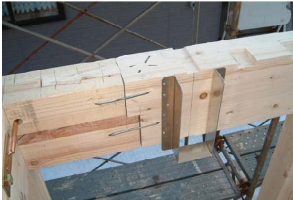
図14 床梁の継ぎ手と金物
