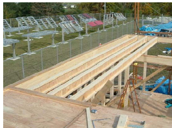
図13 2階床根太の長尺使用
