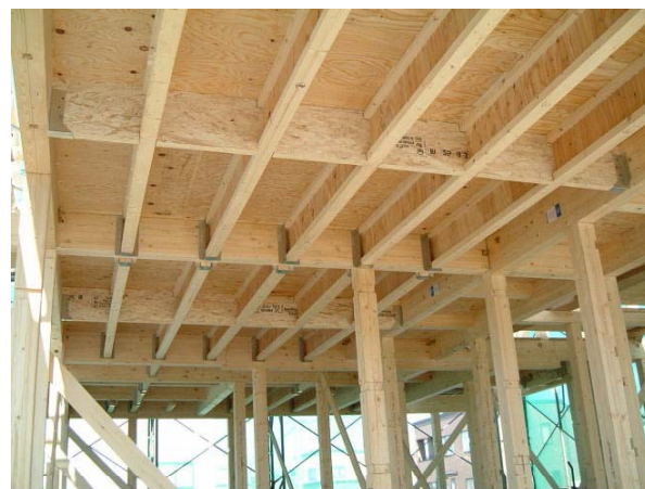
図11 2階床根太と下地合板
