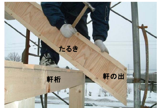
図18 軒桁でのたるき固定
