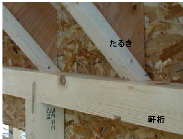
図20 軒の出がない場合のたるき固定
