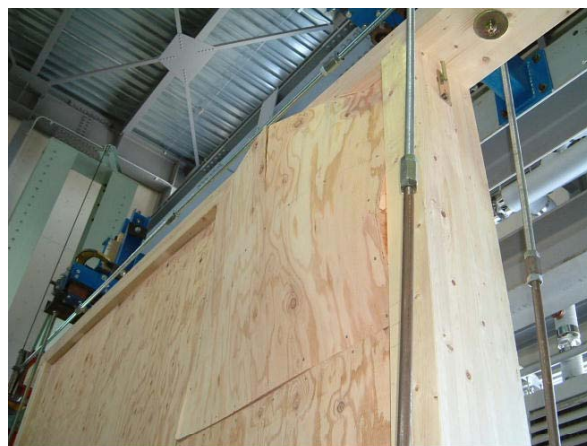
図10 合板の面外座屈(Bタイプ)
