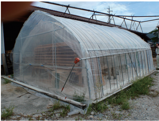
写真1 ビニールハウスを利用した太陽熱乾燥 (長野県松川村)
