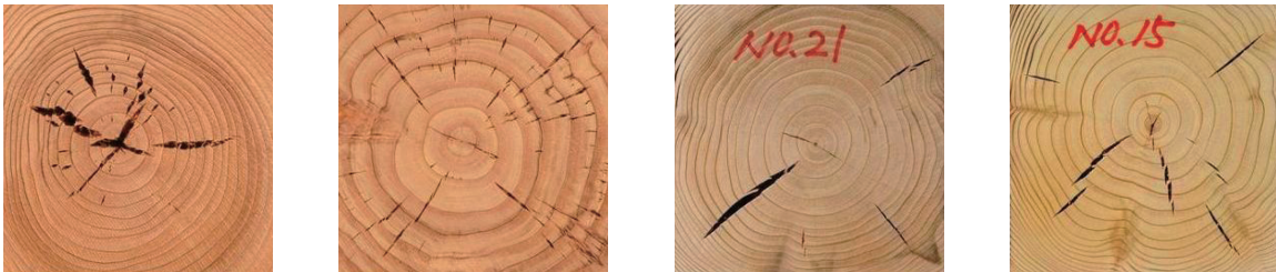
写真 スギ材に発生した様々な内部割れ
