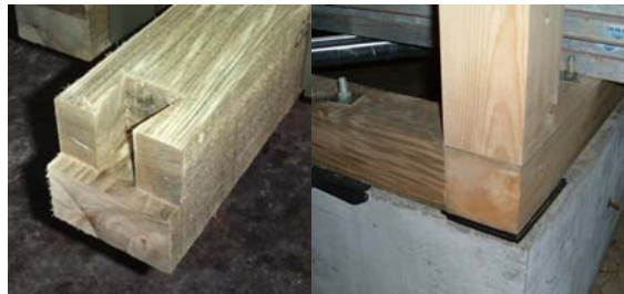
加工後の保存措置
