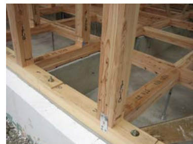
土台とアンカーボルト
