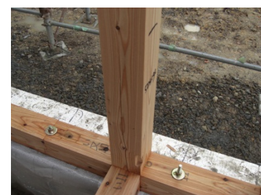
柱と土台の接合部
