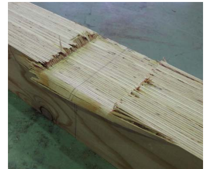
めり込み破壊の様子
