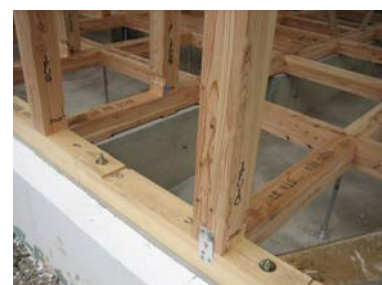
土台とアンカーボルト
