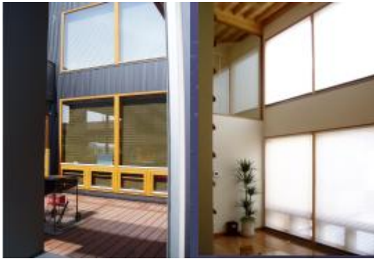
写真4 オープンスペースに面した木製サッシ
