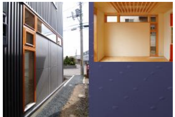
写真6 木製サッシの例（その2）
