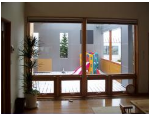
写真5 木製サッシの例（その1）
