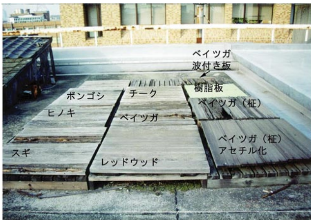
写真4 設置後10年経過した屋上のデッキ類 (2000年1月)
